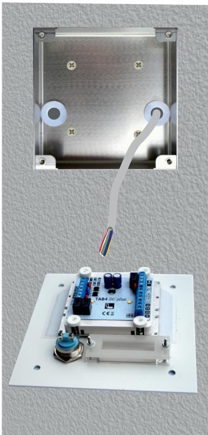
**1** Unterputz-Gehäuse mauerbündig einputzen und rückseitig im Mauerwerk mit den Befestigungsschrauben verankern. Dabei die Anschlussleitung durch die Kabeleinlässe führen. Anschlussleitung Fernmeldekabel z.B. J-Y(ST)Y 4x2x0,6mm<sup>2</sup>. Danach Frontplatte mit dem montierten Türsprechmodul vor dem Unterputz- Gehäuse positionieren. Schaffen Sie dafür eine geeignete Ablagefläche. Schützen Sie die Frontplatte vor Beschädigung.
